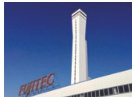
華昇フジテック エレベータ研究塔「翔雲塔」建設 (2014年3月)
