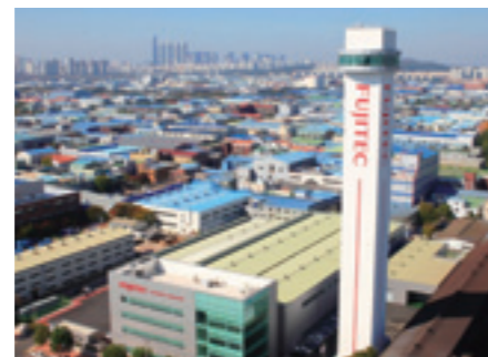
フジテック・코리아 仁川工場リニューアル工事完了 (2014年10月)
